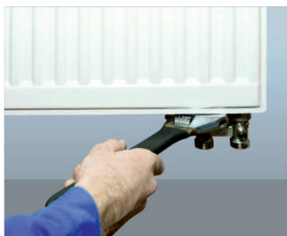
(2) Привинтить узел нижнего подключения радиатора
