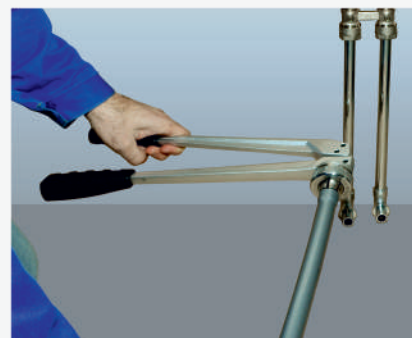
(6) Подвести трубо-провод необходимой длины, затем расширить конец трубы
